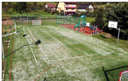
Modernizacja boiska przy SP w Kieczni
