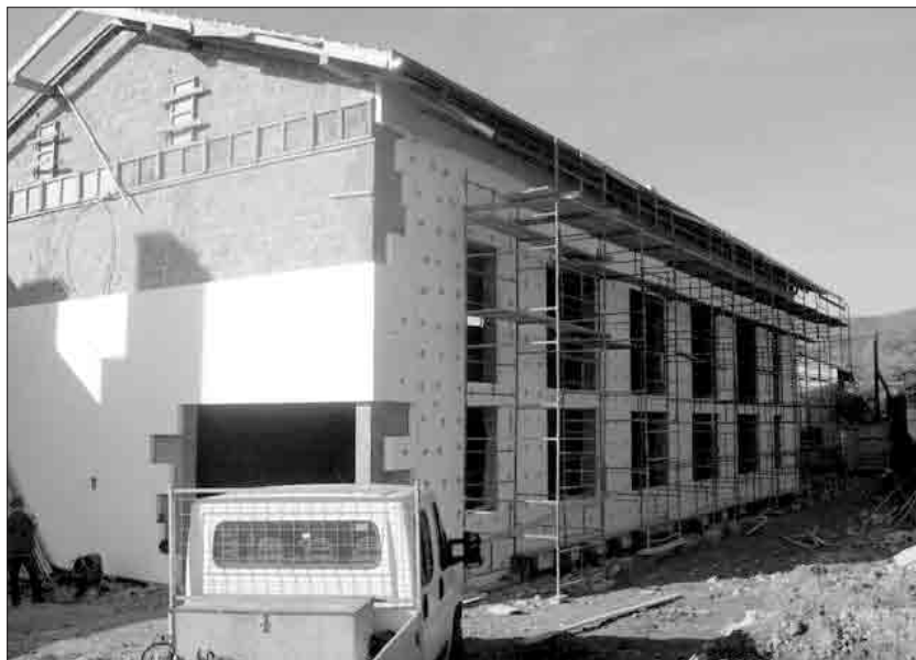
Nowa sala gimnastyczna w budowie
